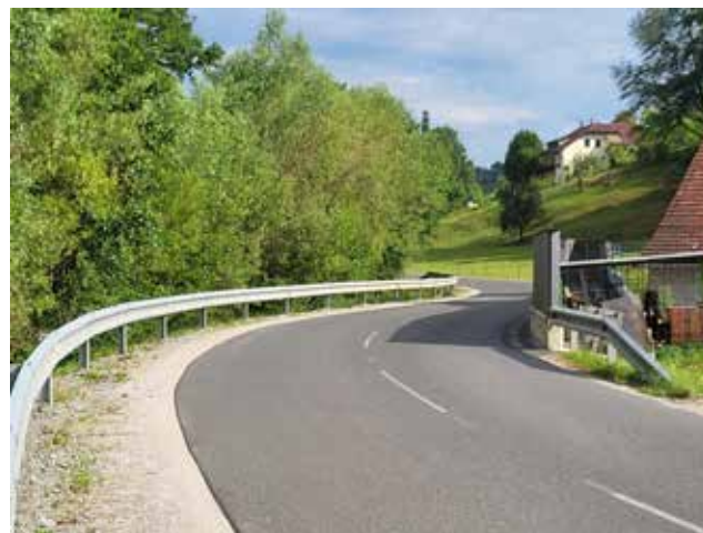
Nevaren odsek za pešce.
