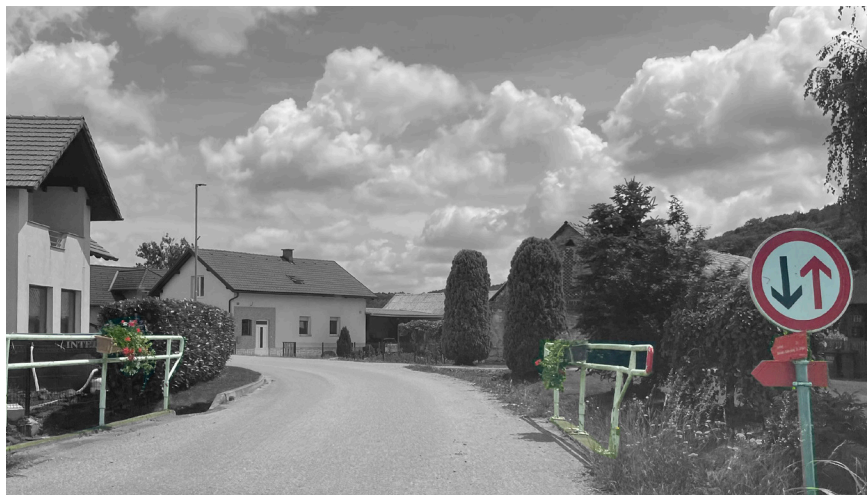
Slika 8: Prikaz zmanjšane pregledne berme v bližini zoožitve ceste
