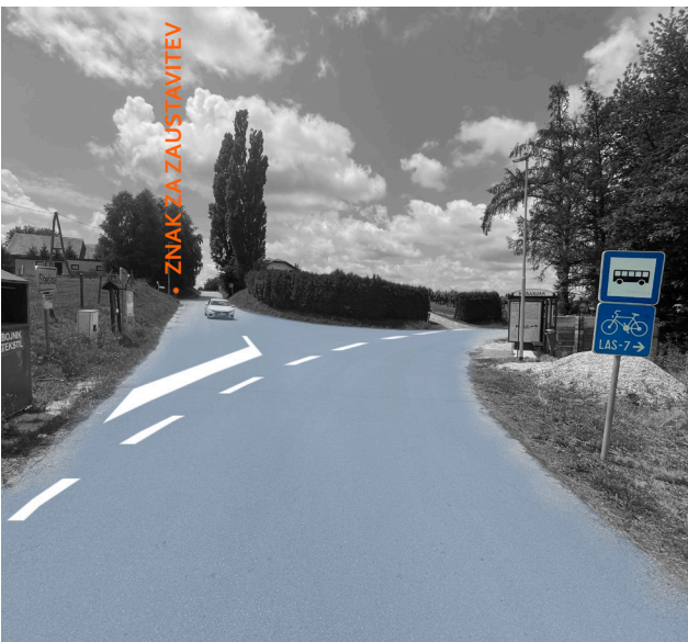
Slika 23: Desno zgoraj - obstoječa situacija križišča v Slavšini, desno spodaj - predlog prometne izboljšave: Na sliki je prikazano križišče, kjer ima stranska cesta prometni znak "Ustavi", vendar ni določeno mesto za zaustavitev s talno označbo ali navedena razdalja za zaustavitev na znaku. Hkrati glavna cesta nima oznake, da je prednostna. Pomanjkanje vertikalne in horizontalne signalizacije v križiščih teh gabaritov pušča udeležencem preveč manevrskega prostora, kar povečuje tveganje za nesreče.
