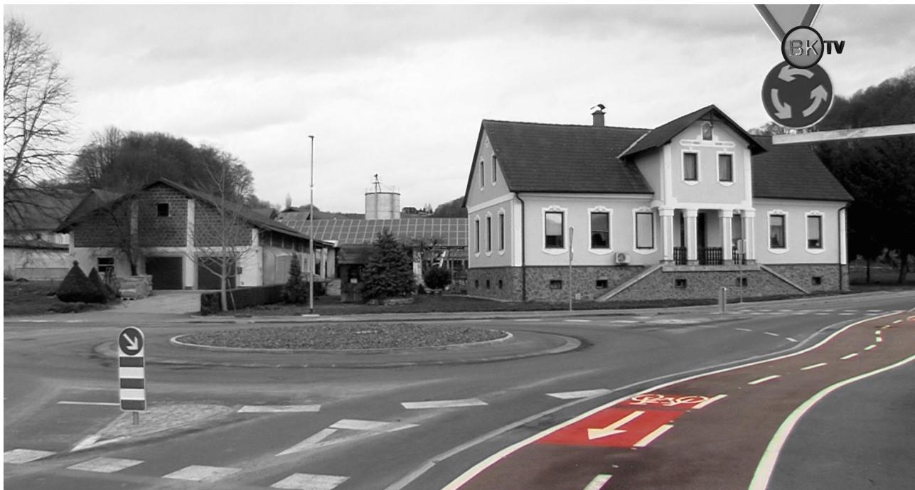
Slika 16 : Krožno križišče v Drbetincih z varno dvosmerno kolesarsko stezo
