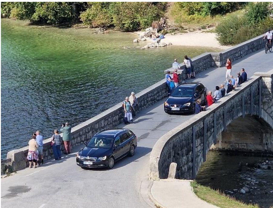
Ozko grlo – most pri cerkvi sv. Janeza Krstnika brez ločenih površin za pešce (in kolesarje)
