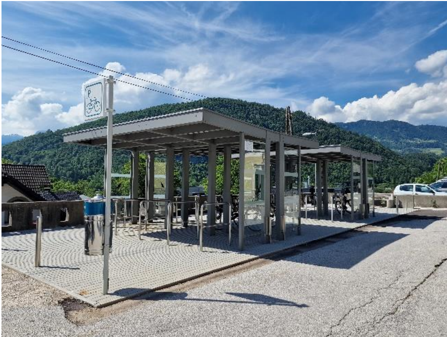
Vzorno urejena kolesarnica s servisno točko na železniški postaji Bohinjska Bistrica
