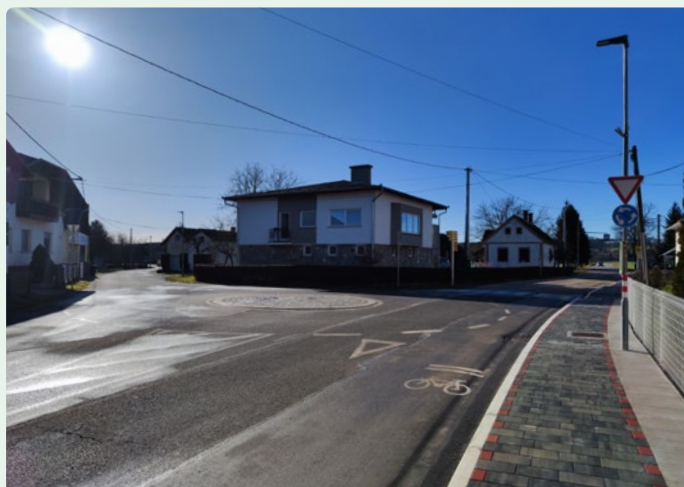
Slika 28: Novo urejeno krožno križišče na občinski cesti LC 169011 (Kobiljska šuma - Kobilje) - izvedeno na mestu nevarnih Y-križišč, kar prispeva k večji preglednosti, umirjanju prometa in izboljšani prometni varnosti
