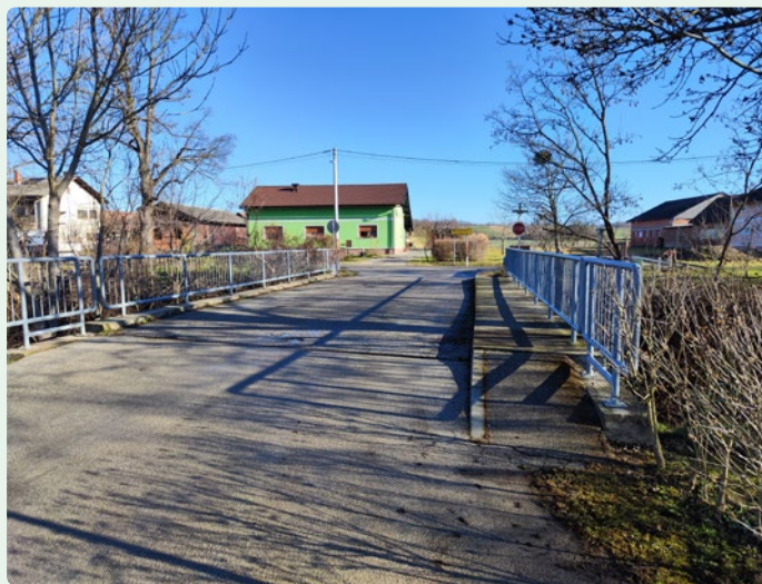
Slika 4: Povezovalni most med občinsko javno potjo JP 765742 in državno regionalno cesto R3-724/4120 Berkovci - Kobilje - urejen denivelirani hodnik za pešce omogoča varno prečkanje premostitvenega objekta
