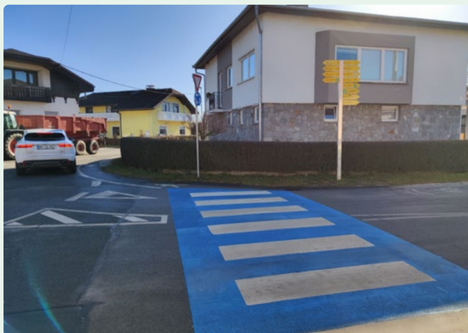
Slika 8: Prehod za pešce, označen z modro barvo, za povečanje varnosti pešcev - učinek povečanja kontrasta in vzbujanja pozornosti voznikov
