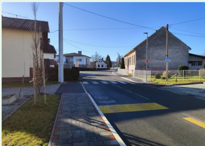
Slika 5: na novo urejen hodnik za pešce ob občinski lokalni cest LC-169011 Kobiljska šuma – Kobilje z varno, estetsko in tlakovano pohodno površino
