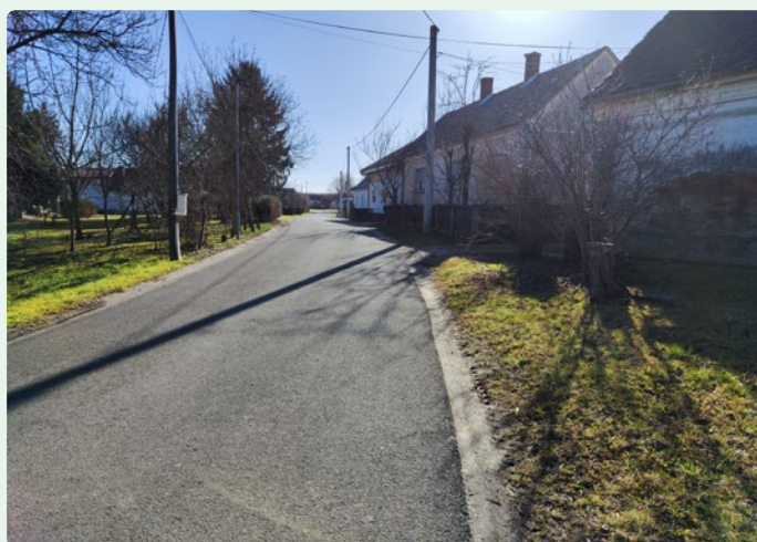
Slika 30: Občinska JP 669061 (R2-MALO KOBILJE-KOBILJE) v naselju Kobilje - ni urejenih hodnikov za pešce, prav tako ni urejenih površin za kolesarje, kar pomeni, da so vsi udeleženci v prometu na istem vozišču, brez ukrepov za povečanje varnosti in pri omejitvi 50 km/h
