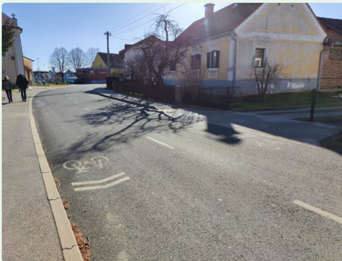
Slika 14: Horizontalna talna označba na občinski lokalni cesti LC-169031 (Kobilje), ki opozarja na prisotnost kolesarjev na vozišču in s tem povečuje njihovo vidnost ter varnost v prometu
