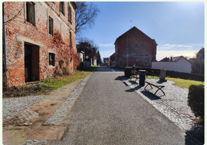
16. ábra: Az Alsó utca különálló felületekkel van kialakítva – központi aszfaltozott sáv a járművek számára és burkolt szegélyek a gyalogosok számára –, ami jobb áttekinthetőséget és a forgalom lassítását teszi lehetővé. A pad jelenléte az első nyomtatott könyv emlékművénél további hangsúlyt ad a hely kulturális jelentőségének, és lehetőséget nyújt a pihenésre a rendezett városi térben.
