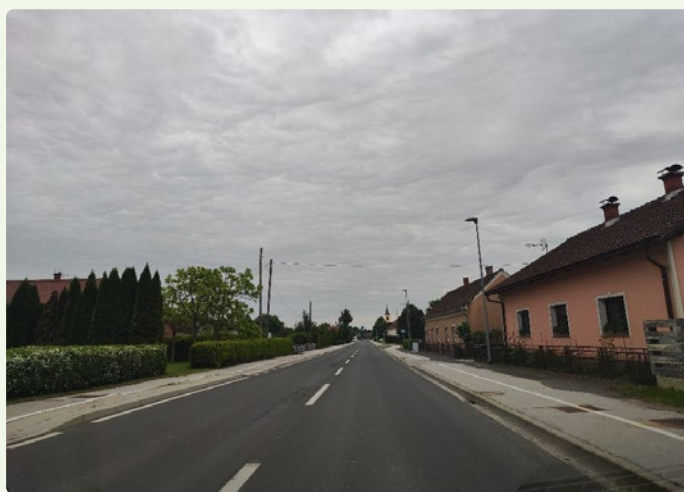
22. kép: A járdák kétoldali rendezése, külön sávokkal a gyalogosok és a kerékpárosok számára, hatékonyan javítja a közlekedés biztonságát és ösztönzi a fenntartható mobilitást. A további rendezés során érdemes megfontolni a járda kiegyenlítését a bekötőutak területén, a magasság csökkentése nélkül, ami megszünteti az úgynevezett „tevehatást” és egyértelműen előnyben részesíti a gyalogosokat és kerékpárosokat a motoros forgalommal szemben, összhangban a modern közlekedéstervezés elveivel.
