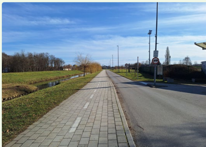
27. kép: A JP707391 helyi út mentén, Lendván, a Vasút utcán kialakított szintkülönbséges kerékpárút minőségi közlekedési megoldást jelent, amely egyértelműen elválasztja a kerékpáros forgalmat a motoros forgalomtól. A pálya és a kerékpárút közötti magasságkülönbség növeli a kerékpárosok biztonságát.
