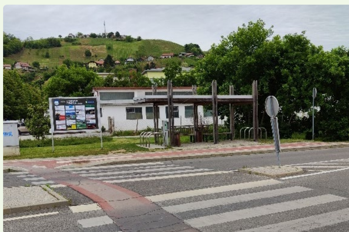
37. kép: Fedett kerékpártároló az LK 207611 (Vasút utca 3C) Lendva kereskedelmi központjában, közvetlenül a lendvai buszmegálló közelében található – multimodalitás, a tömegközlekedés és a kerékpározás kombinálásának ösztönzése hozzájárul a városban a komplex, fenntartható mobilitás fejlesztéséhez.
