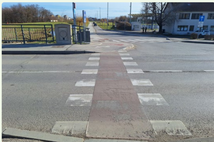
28. kép: A LZ206501-es községi út mentén kijelölt kerékpáros átkelőhely biztonságos és egyértelmű közlekedési kapcsolatot biztosít a Fő utca és a Vasút utca között, és folytonosságot teremt a JP707391-es út mentén található kerékpárrúttal.
