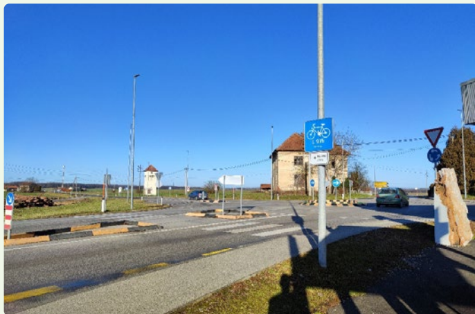
62. kép: Az R2-442/1319 (Dobronak- Hosszúfalu körforgalom) állami út és az LK 207601 (Iskola utca Göntérházán) és LC 430011 (Turnišče–Göntérháza) kereszteződésében ideiglenes körforgalom került kialakításra, előre gyártott közlekedési elemek felhasználásával. A kialakítás biztosítja a forgalom zavartalanabb és biztonságosabb áramlását, csökkenti a konfliktushelyzetek lehetőségét, és lehetővé teszi a sebesség csökkentését, különösen az iskolai útvonalak bekapcsolódásánál és a településekhez való hozzáféréseknél.
