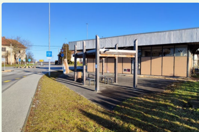
36. kép: A fedett kerékpáros pihenőhely a R2-442/1319 Dobronak–Hosszúfalú körforgalom melletti regionális úton Göntérháza településen biztonságos és az időjárás viszontagságaitól védett helyet kínál a kerékpárosoknak pihenésre vagy kerékpárjuk tárolására.
