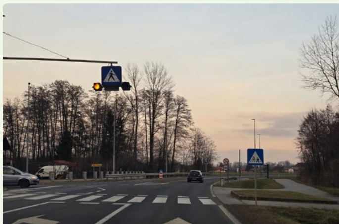
39. kép: A KJ 970611 közúti kerékpárút a Grede–Hotiza szakaszon a R2-443/0322 Črenšovci–Alsó Lakos regionális úton halad tovább, kerékpárosok számára kialakított átkelőhellyel. A közlekedési rendszer lehetővé teszi az állami út biztonságos átkelését.
