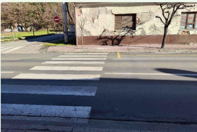
17. kép: A Fő utca gyalogos átkelőhelye megfelelően leeresztett szegélyek nélkül korlátozza a fogyatékkal élők, az idősek és a babakocsival közlekedő szülők hozzáférést, ezért alacsony szegélyek kialakítása és a járdával való egy szintbe hozása ajánlott a közterület minden felhasználója számára biztonságos és akadálymentes használatának biztosítása érdekében.
