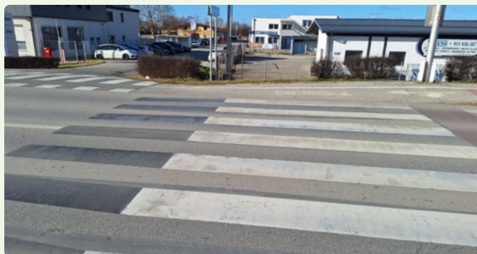
6. kép: 3D gyalogos átkelőhely a LZ-206501-0048 Vasút utca – Fő utca községi úton – hatékony intézkedés a forgalom lassítására és a gyalogosok biztonságának növelésére. Az optikai illúzió miatt a járművezetők ösztönösen csökkentik a sebességüket, ami különösen fontos a községi utakon, ahol nagyobb számban vannak jelen a sérülékeny közlekedők.
