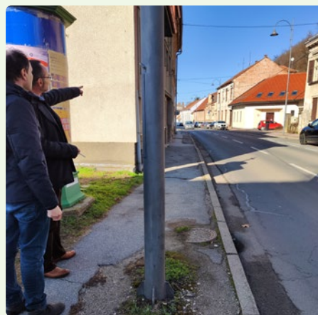
18. ábra: A gyalogos átkelőhely közepén álló kandeláber térbeli akadályt jelent, és csökkenti a forgalom áramlását és a biztonságot a kiszolgáltató csoportok, különösen a csökkent mozgásképességű személyek számára. Ezenkívül a kopott aszfaltréteg az egyenetlen felületű járdán a kopottság jele, ezért célszerű a felület teljes felújítása és az akadályok áthelyezése a fő gyalogútvonalon kívülre.
