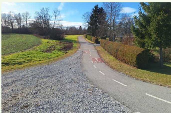
30. kép: A Ledava folyó mentén húzódó kerékpárút csatlakozása a JP 706331 Hármasmalom-Zatak úthoz, ahol talajjelzésekkel egyértelműen jelzik a kerékpárosok jelenlétét az úton. Az ilyen közlekedési rendezés felhívja a gépjárművezetők figyelmét az út közös használatára, és növeli a kerékpárosok biztonságát olyan területeken, ahol nem lehet külön kerékpáros infrastruktúrát biztosítani.
