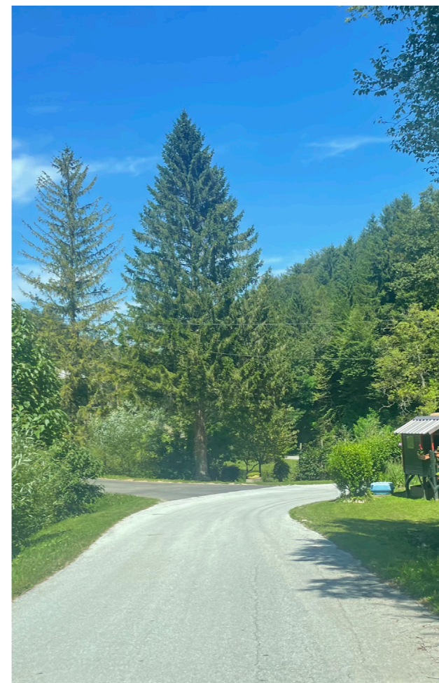
Slika 7: Na sliki je razvidno, da vegetacija neposredno ob cestišču zasebne parcele sega v bermo ob lokalni cesti, in sicer na nepreglednem odseku v ovinku v desno. Takšno stanje zmanjšuje preglednost in lahko vpliva na varnost prometa. Priporočljivo je, da se zasaditve tega tipa umaknejo iz varovalnega pasu ceste v skladu z določili Zakona o cestah, ki določa, da obcestni prostor mora ostati prost ovir.
