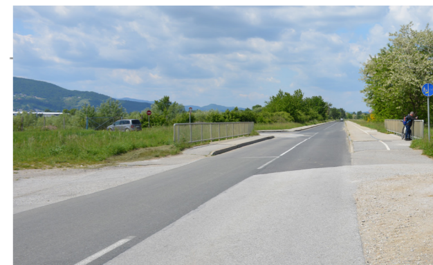
Slika 7: Nepovezana površina za kolesarje in pešce na Letališki cesti z neustrezno vertikalno označbo - pešec je voden ob cestišču med avtomobilom in kolesarjem
