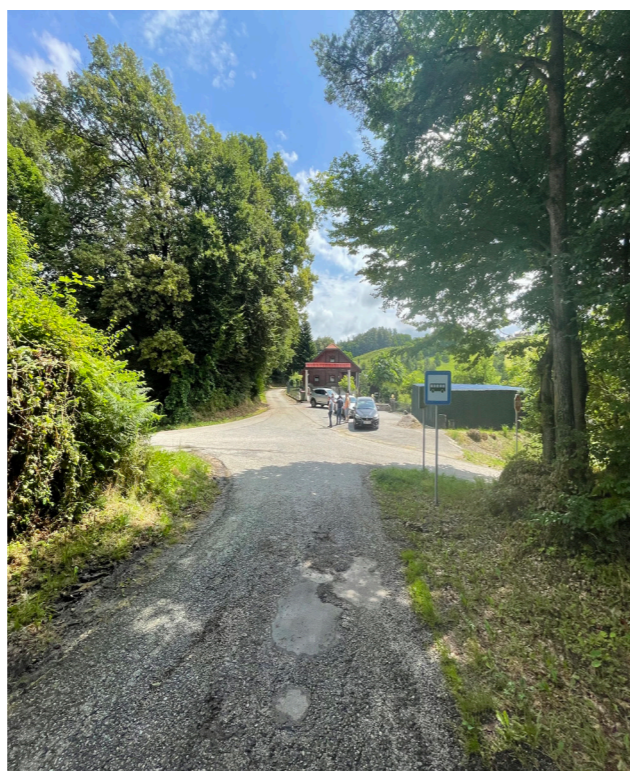
Slika 14: Primer avtobusnega postajališča v križišču cest, brez primerne signalizacije in potrebne ureditve, ki bi zagotavljala varnost predvsem ranljivejših udeležencev v prometu – ta lokacija predstavlja eno izmed potencialno prometno nevarnih točk
