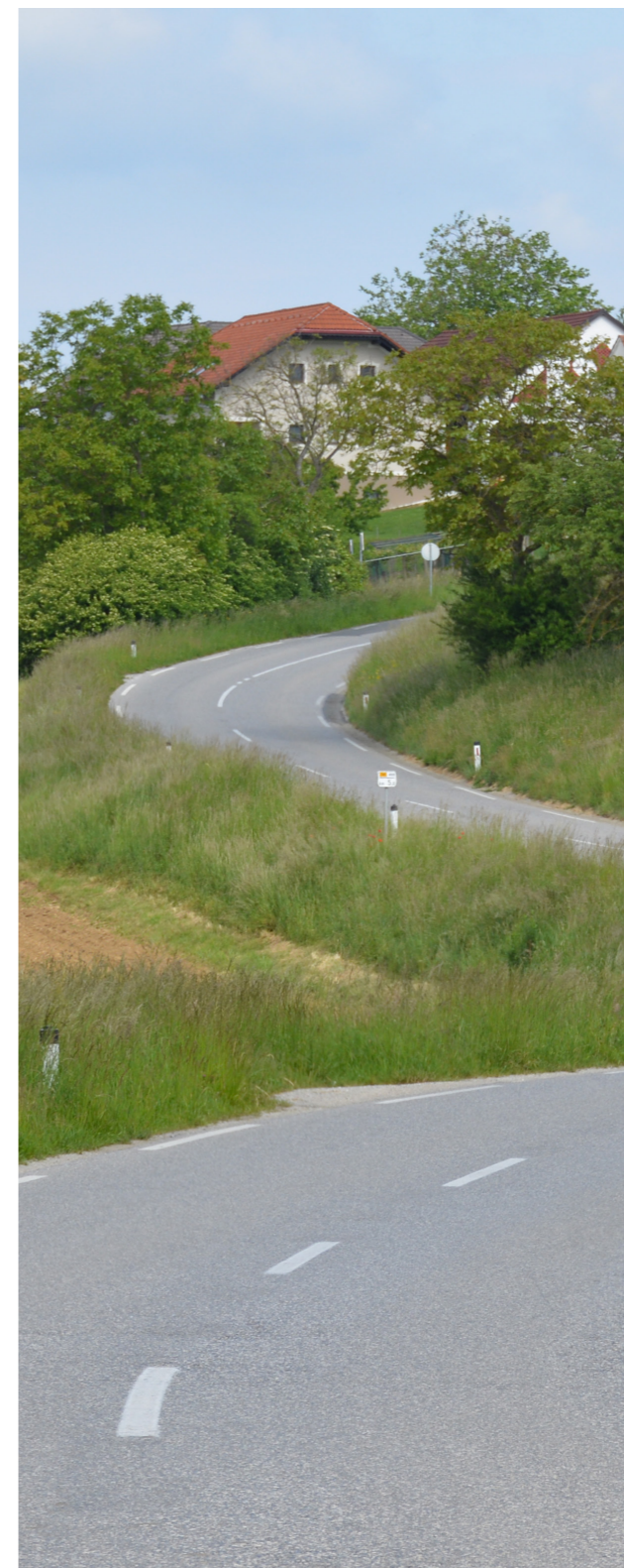
Slika 13: Cestna infrastruktura se prilagaja razgibanemu terenu
