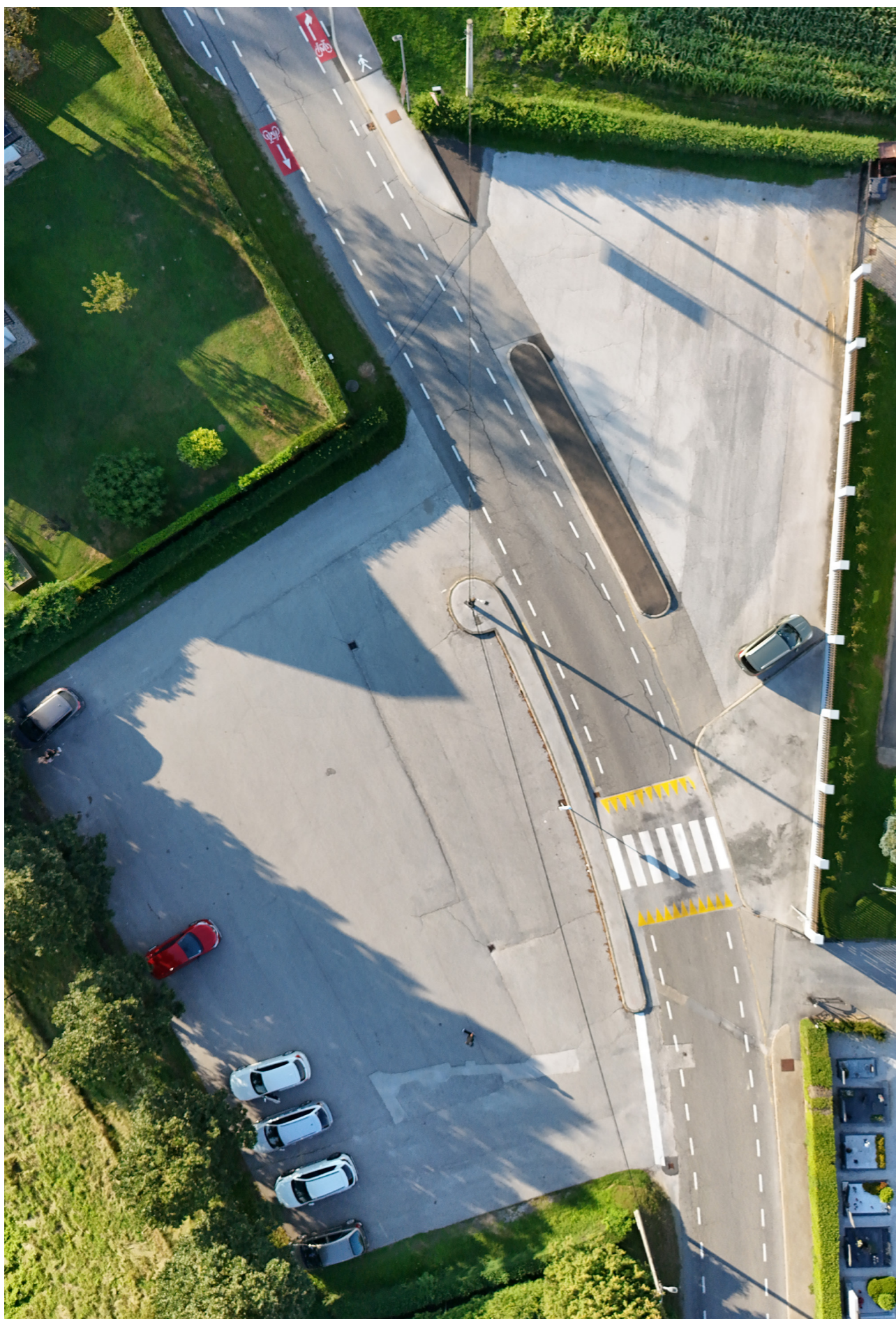
Slika 8: Parkirni prostor ob pokopališču in prometno varna ureditev, ki pa potrebuje več pozornosti pri vodenju prometa na parkirnem prostoru in vzdrževanju talnih označb
