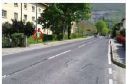
Slika 2.1: Lokacija meritev na glavni cesti 02-103/1008 Ulinča-Plava v km 17,537 v bližini objekta Srebrnolova ulica 28 v naselju Deskle
