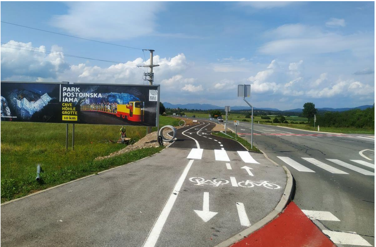
Izgradnja kolesarske steze Selce Pivka
