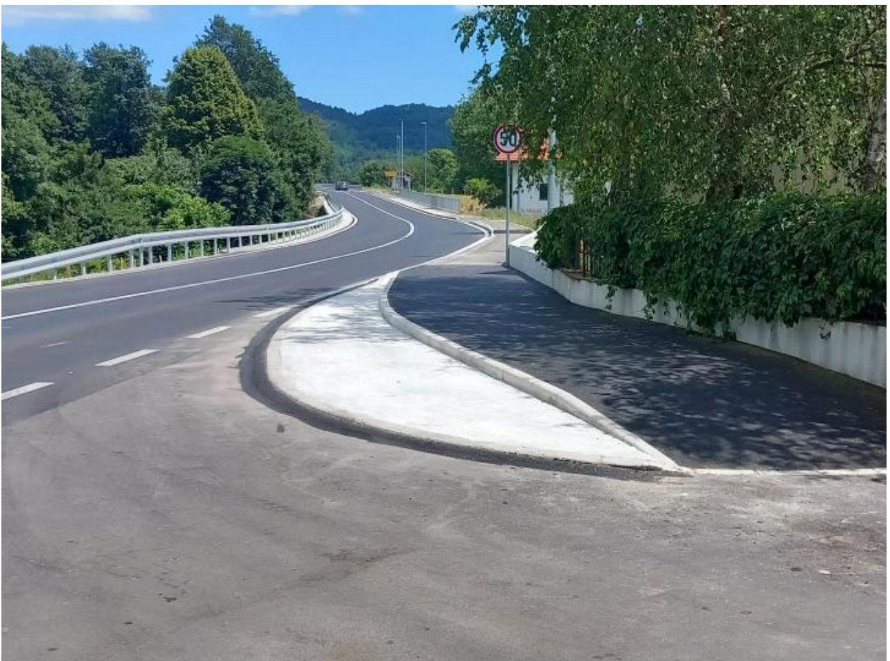
Izgradnja enostranskega pločnika od križišča za Šmihel do križišča za Nadanje selo
