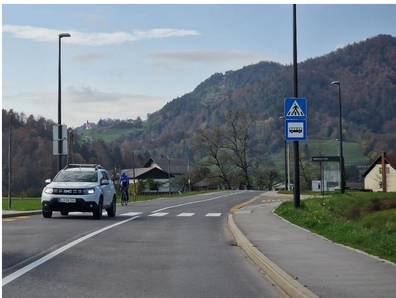
Urejen pločnik s prehodom za pešce in avtobusnim postajališčem v Srednji vasi.
