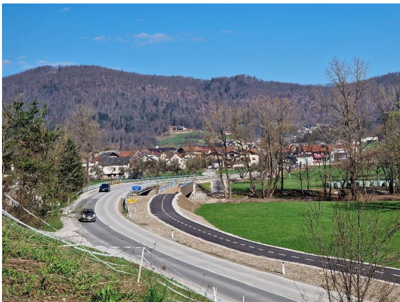
Nova kolesarska povezava med Razori in Gabrjem pripomore k večji varnosti in privlačnosti kolesarjenja v občini.
