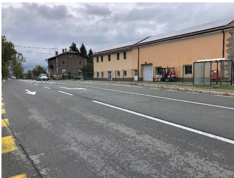
Slika 18: Številni manjkajoči ali nevarni prehodi za pešce na glavni cesti G1-7 Kozina – Starod
