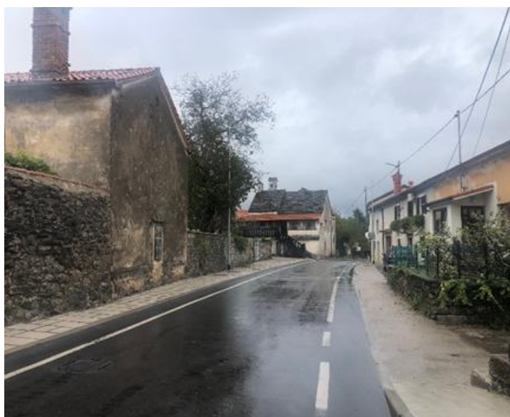
Slika 13: Celovito prenovljena Kraška cesta v Divači (urejene površine za pešce, vodenje slepih in slabovidnih)
