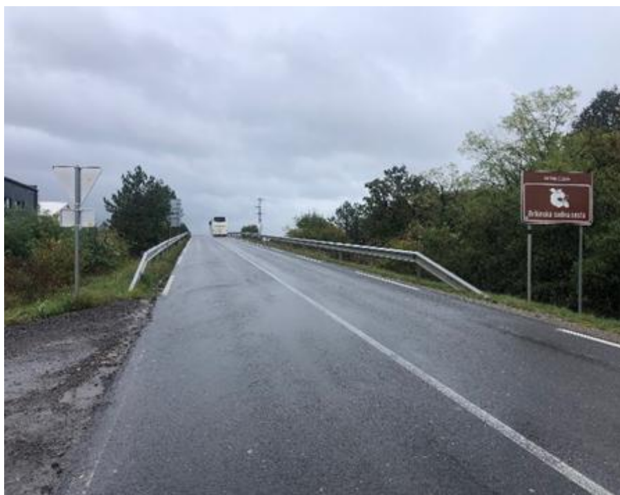
Slika 12: Manjkajoči pas za pešce in kolesarje med naselji Divača in Dolnje Ležeče (nadvoz nad avtocesto - šolska pot)
