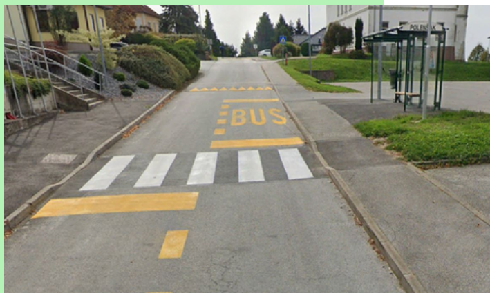
Slika 15: Urejeno avtobusno postajališče z nameščeno osnovno opremo, kot je klop, informacijska tabla in vozni red, Polenšak
