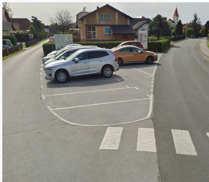
Slika 20: Prikaz parkirnih prostorov na majhnem parkirišču neposredno ob križišču, ki ne omogočajo varnega vključevanja v promet., Dornava
