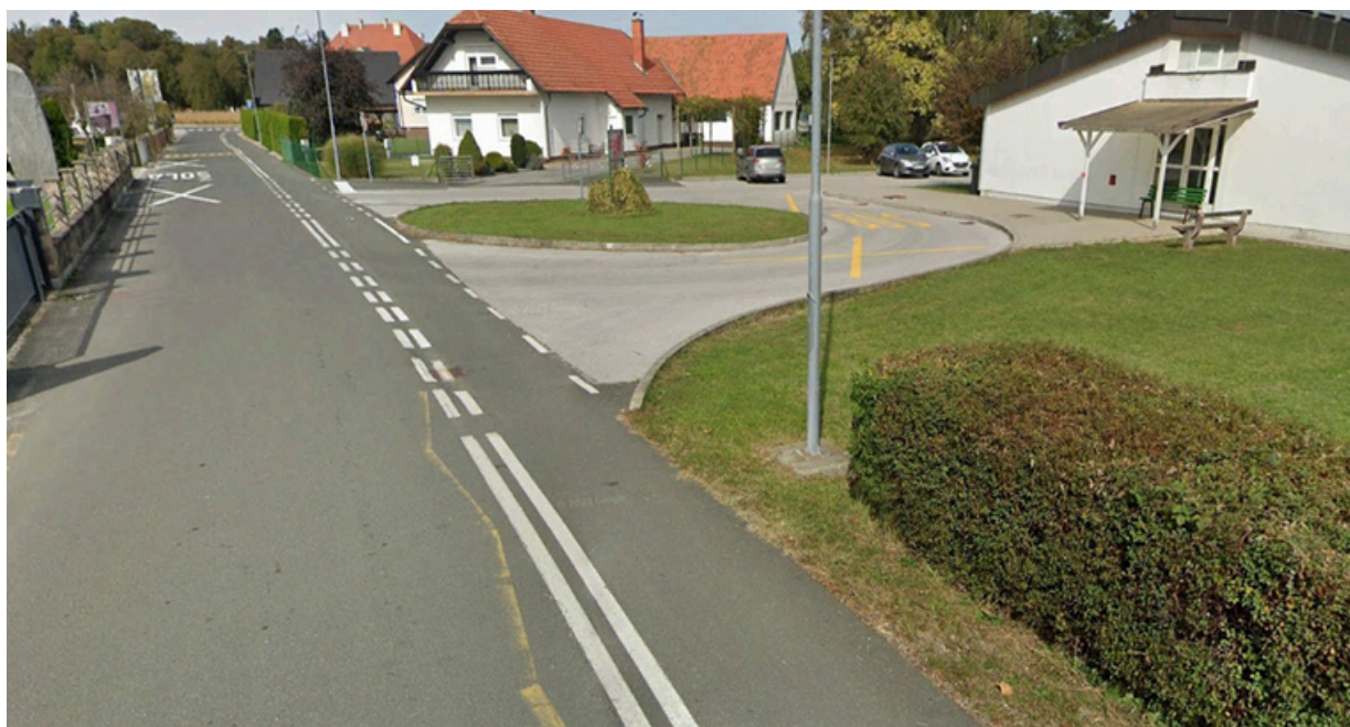
Slika 17: Avtobusno postajališče ob Osnovni šoli Dornava je funkcionalno zasnovano z ustreznimi zavijalnimi radiji in širino vozišča, vendar mu manjkajo ključni elementi udobja in varnosti, kot so zavetje za čakajoče učence, ustrezne klopi ter koš za odpadke. Poleg tega dostop pešcev z lokalne ceste do šole ni jasno in varno urejen.
