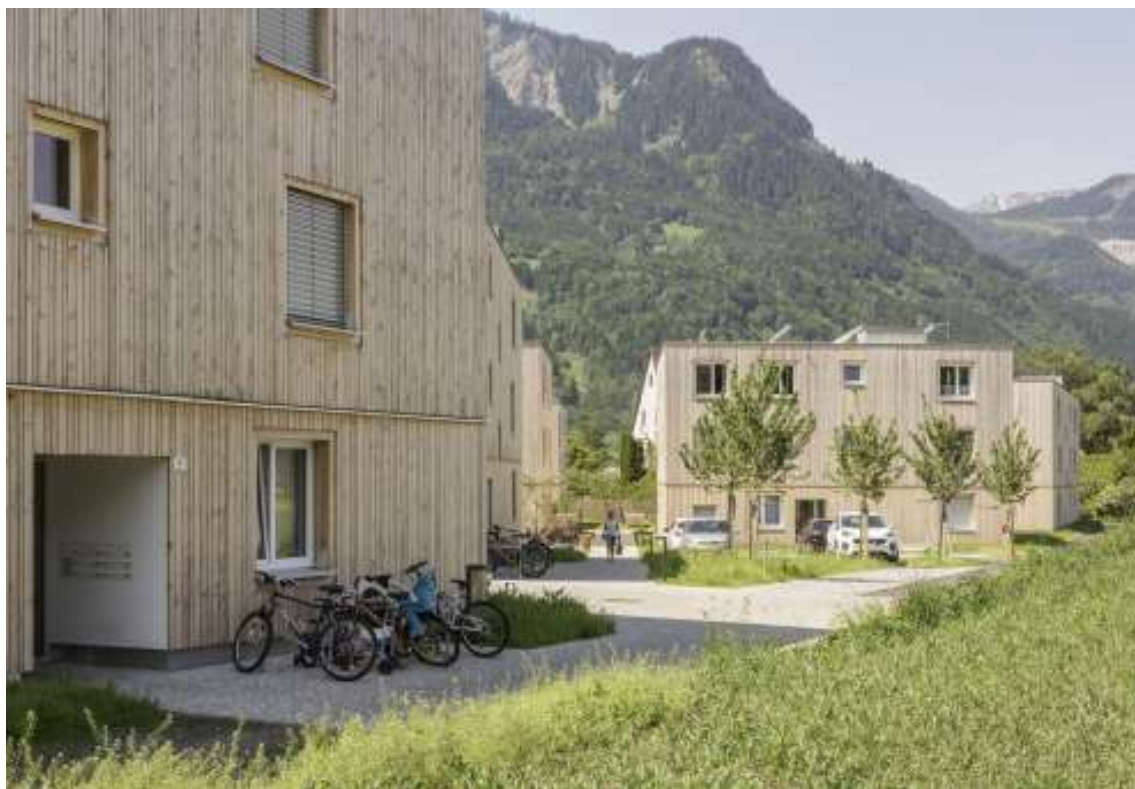
20 | Pogled na vhod stanovanjske stavbe
