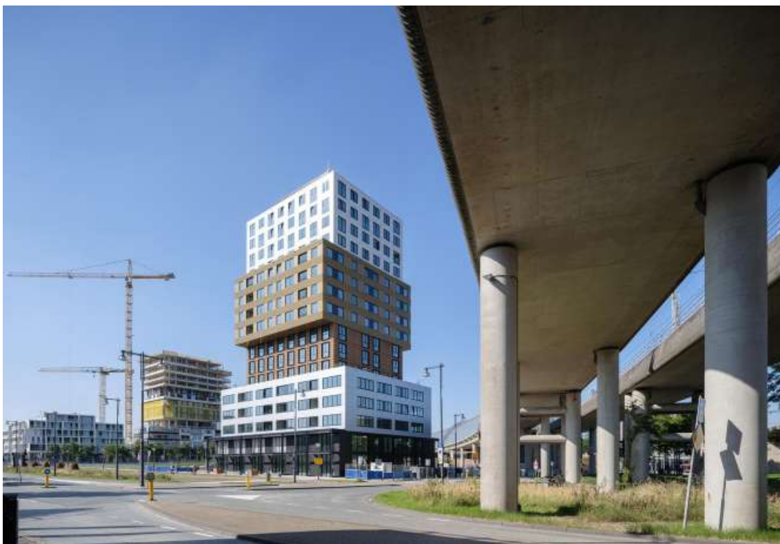
36 | Pogled na stavbo z dostopne ceste
