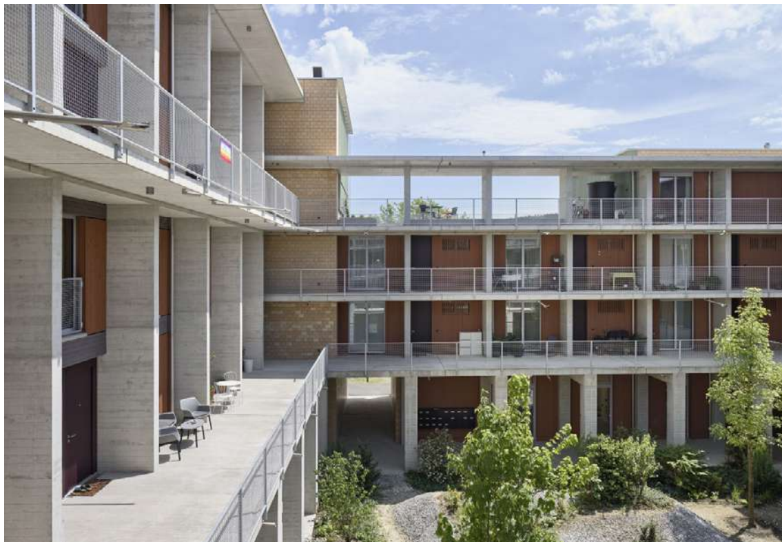
2 | Stanovanjska stavba Haus A
