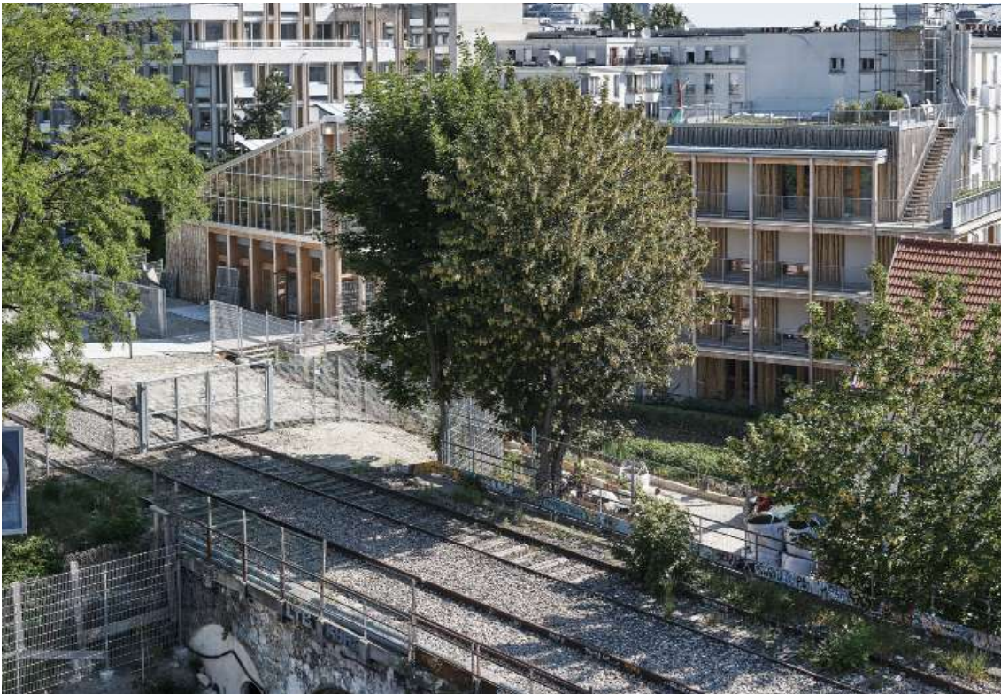
46 | Stavba ob opuščnem železniškem tiru
