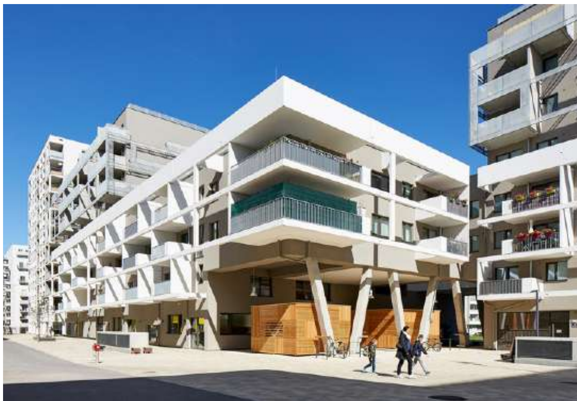
38 | Pogled na vhodno fasado
