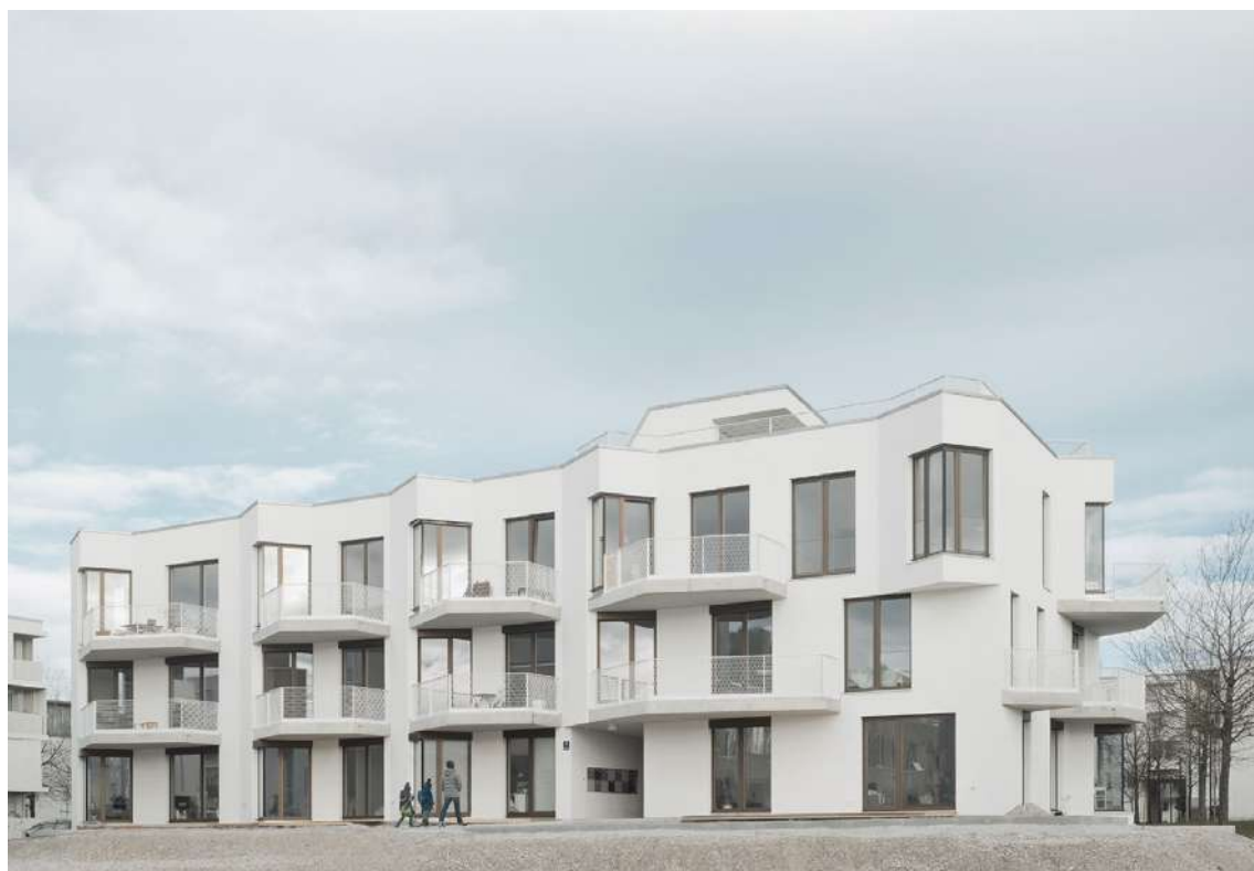
16 | Pogled na vhodno fasado
