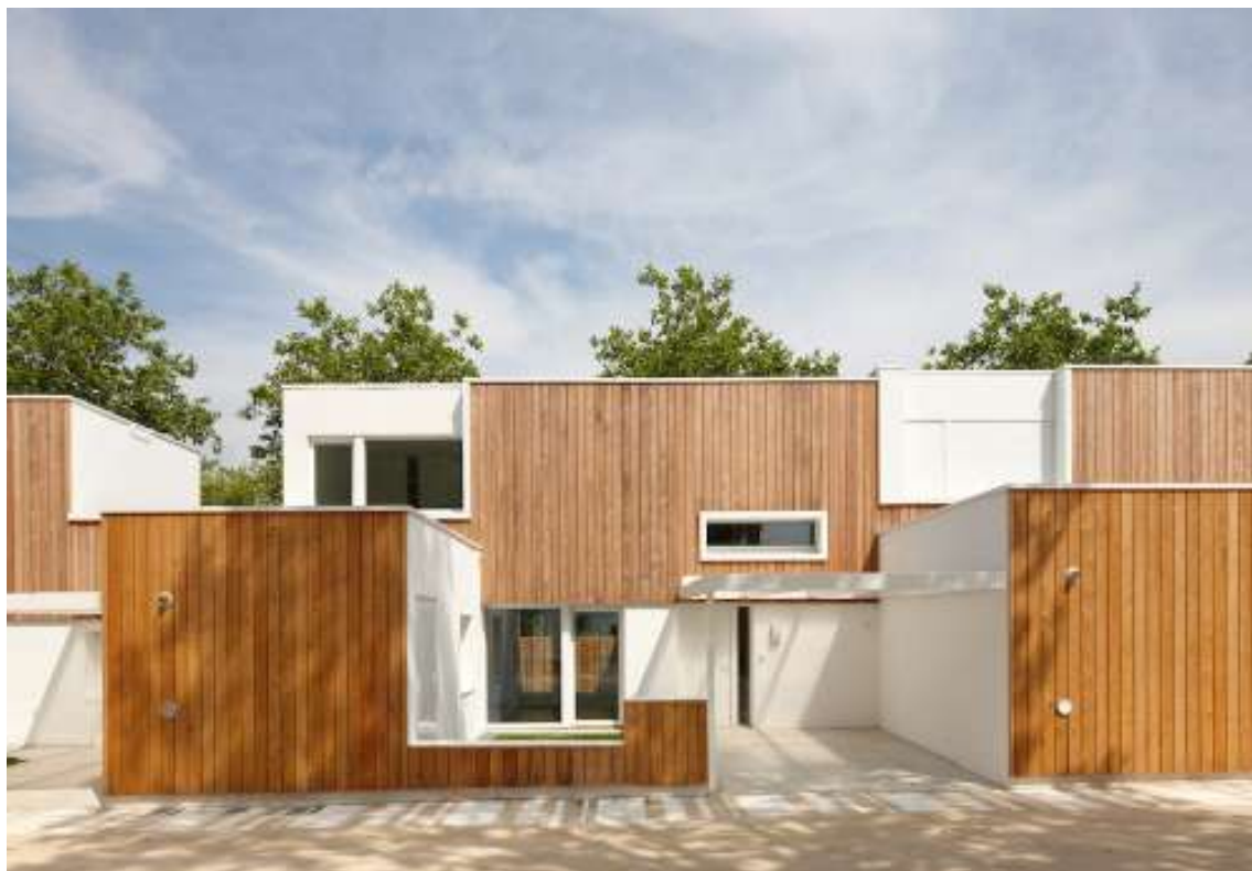
33 | Pogled na vhodno fasado
