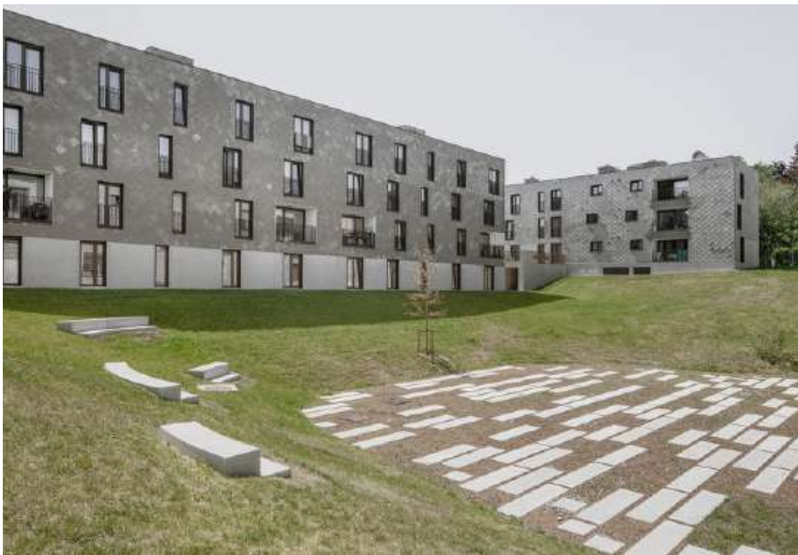
28 | Pogled na skupni zunanji prostor
