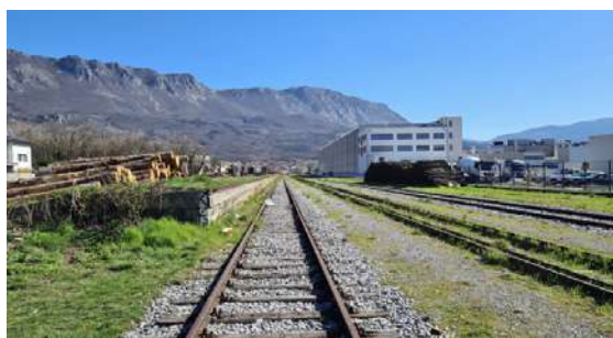
Slika 52: Obstoječi železniški tiri
