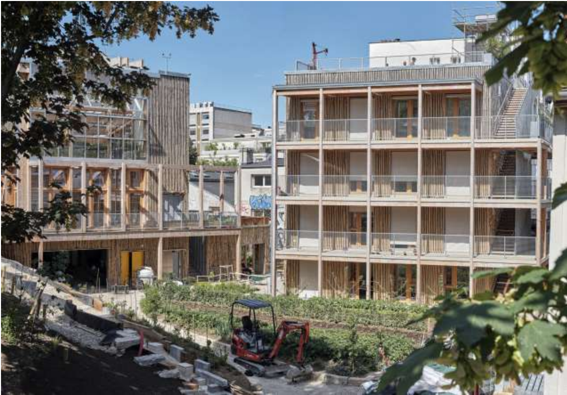
45 | Pogled na stavbo in skupne površine
