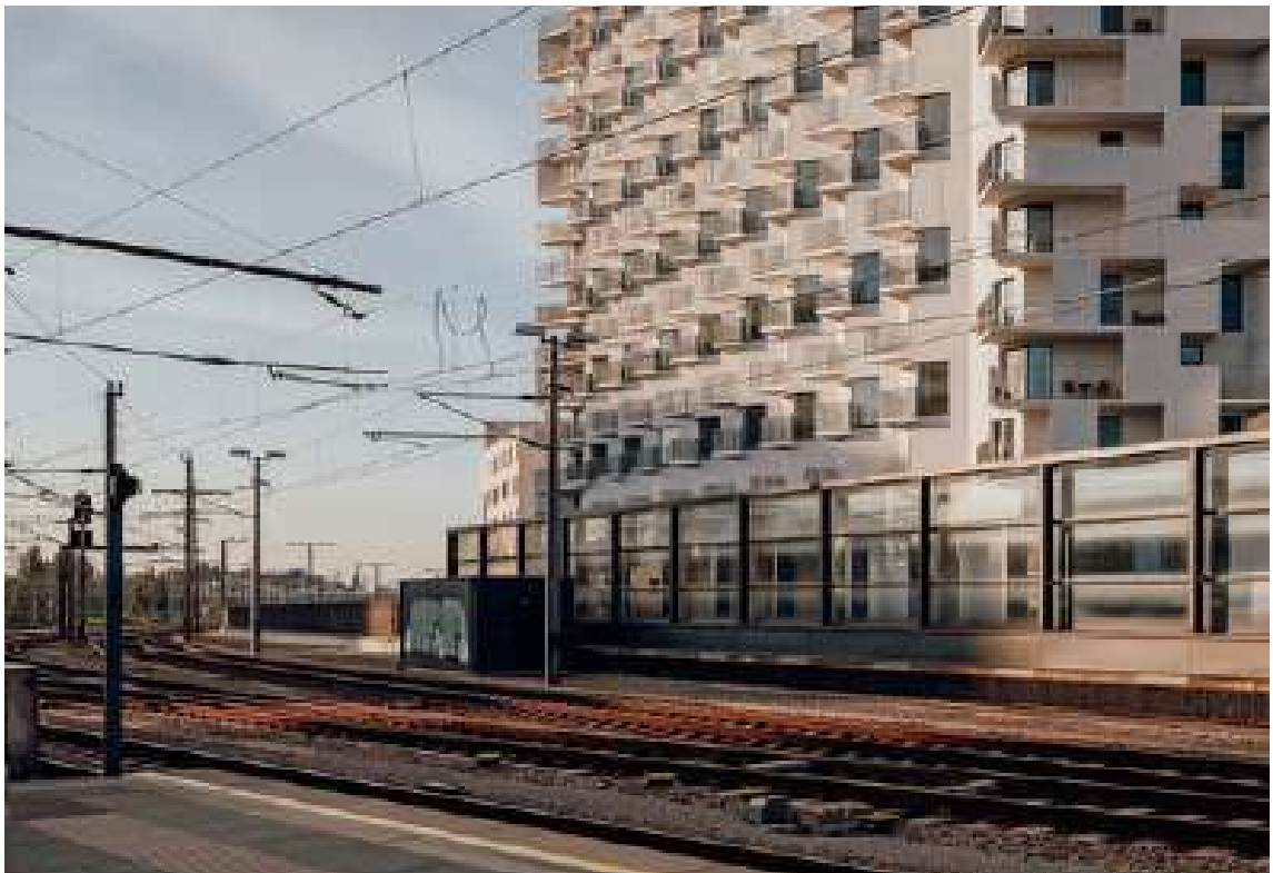
48 | Stavba ob železniški progi
