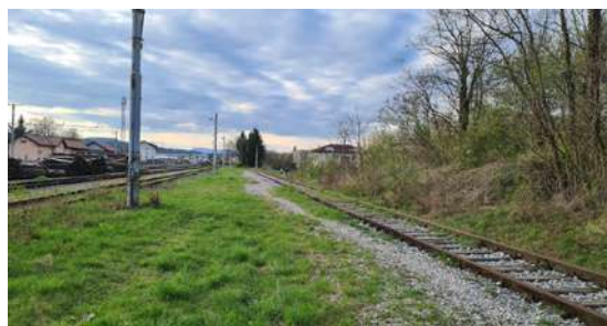
Slika 13: Obstoječi železniški tir
