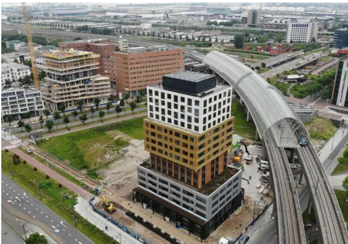
35 | Pogled na stavbo iz zraka
