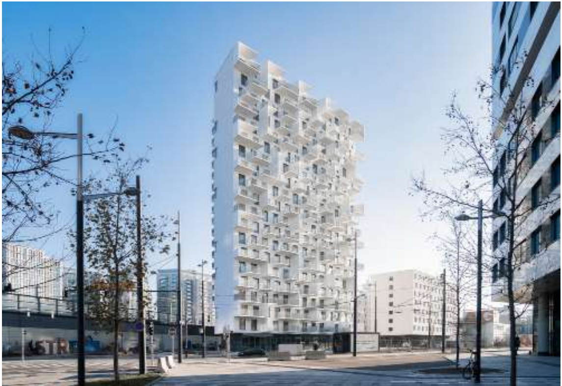
47 | Stavba med železniško progo in prometnico
