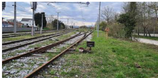
Slika 12: Obstoječa železniška infrastruktura
