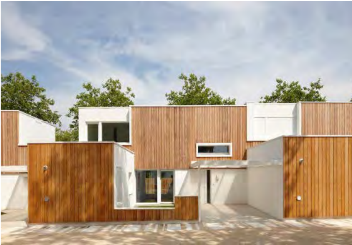
33 | Pogled na vhodno fasado
