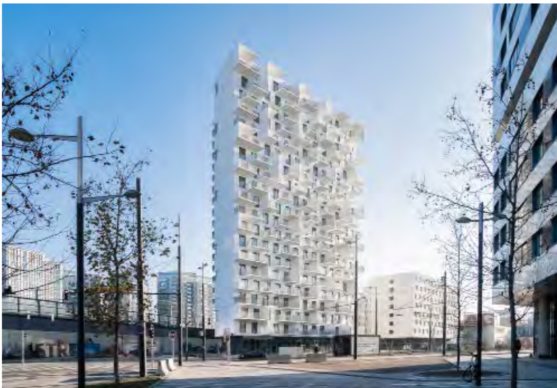
47 | Stavba med železniško progo in prometnico
