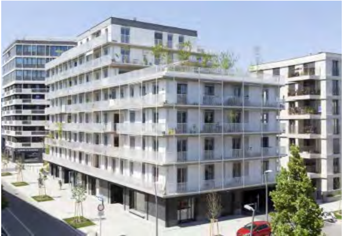
7 | Pogled na stanovanjsko stavbo (vir: https://www.kohlenrutsche.at/haus-2/ , dostopano: november 2025)
