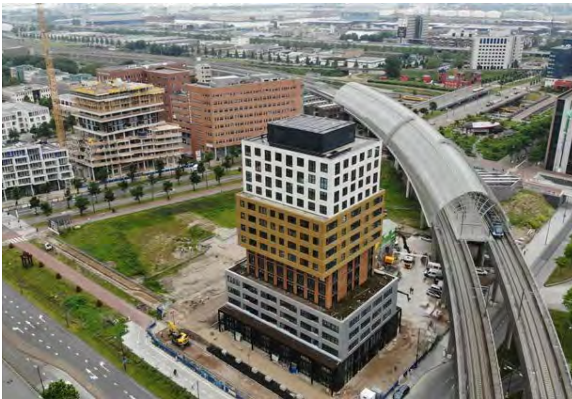
35 | Pogled na stavbo iz zraka
