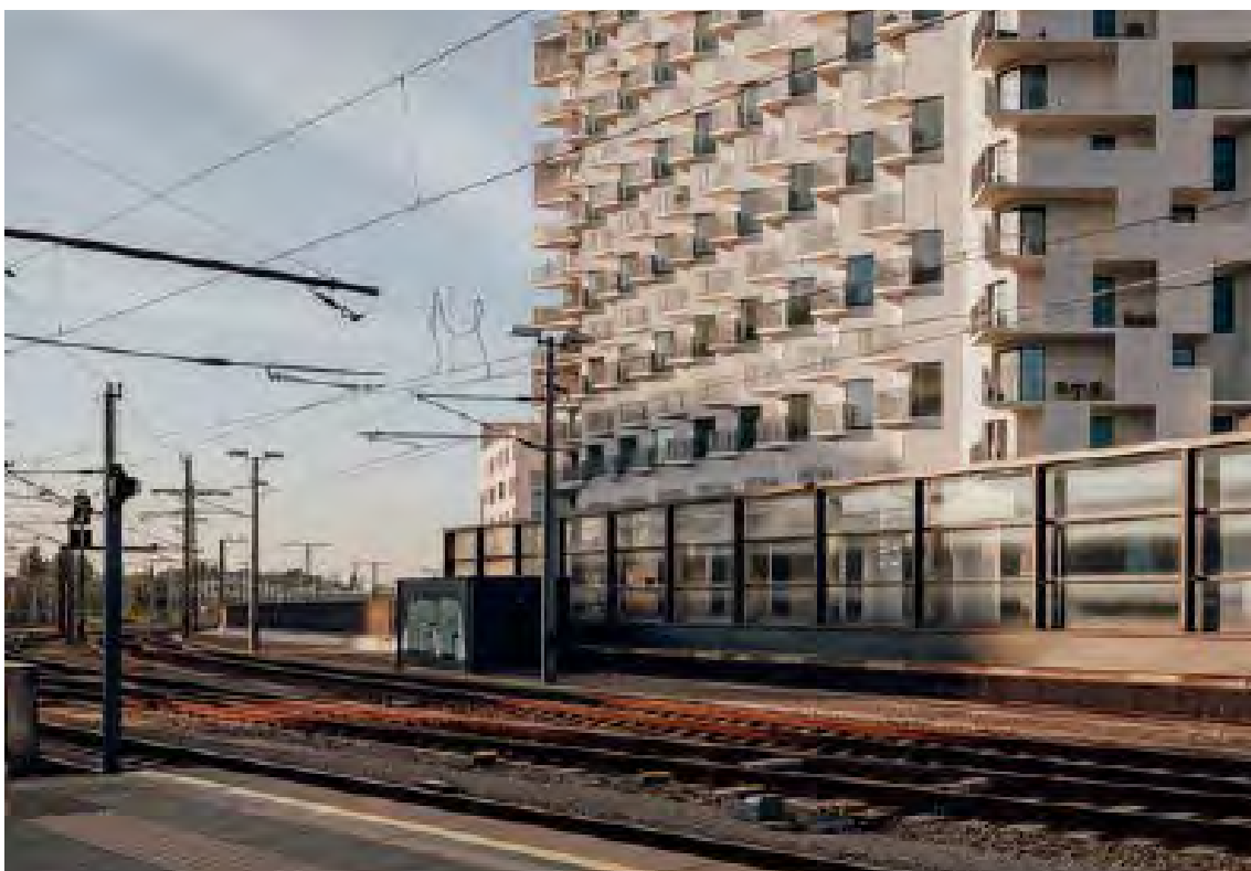
48 | Stavba ob železniški progi
