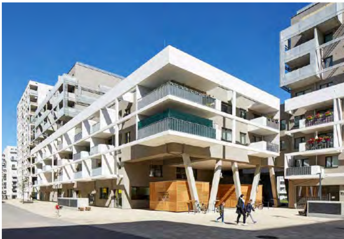
38 | Pogled na vhodno fasado
