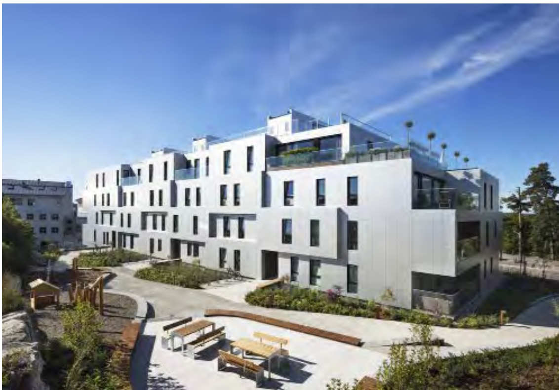
51 | Pogled na stavbo iz atrija (vir: https://archello.com/project/saeter-terrasse , dostopano: november 2025)
