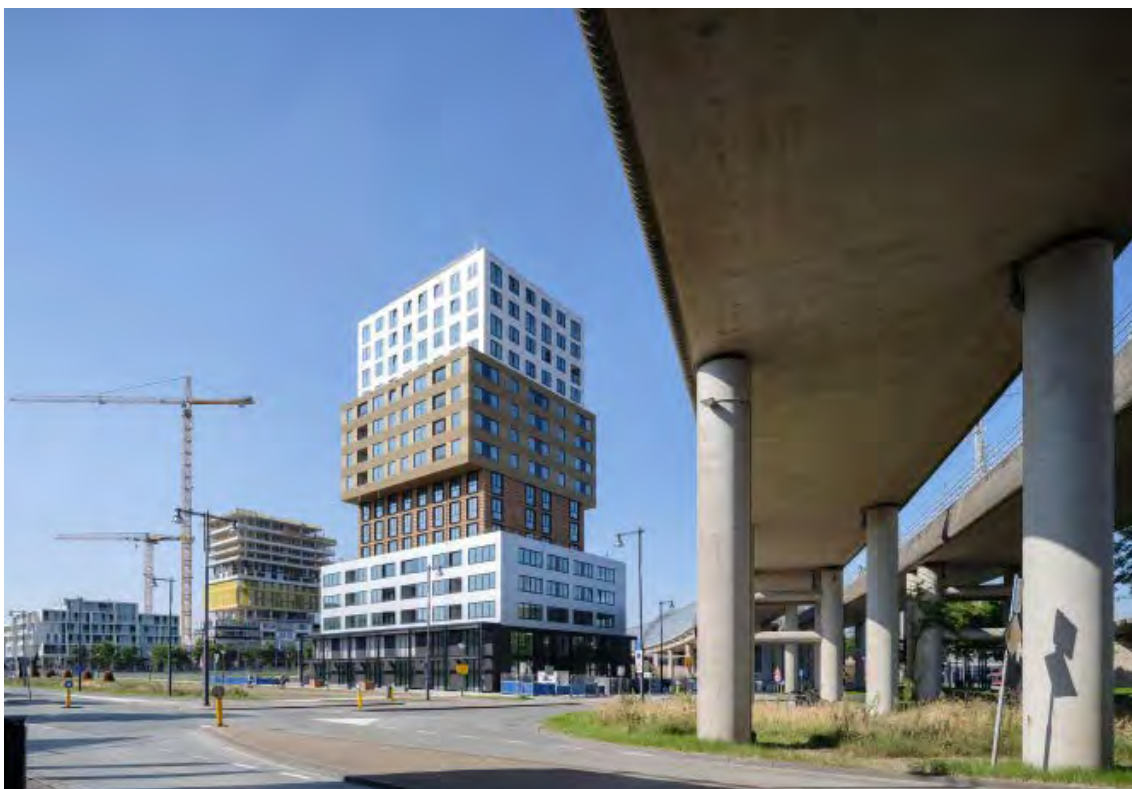
36 | Pogled na stavbo z dostopne ceste
