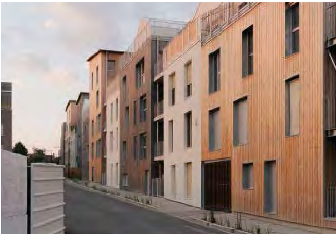
12 | Pogled na stanovanjske stavbe ob dostopni cesti (vir: https://www.arch2o.com/newood-housing-la-architectures-aqma/ , dostopano: november 2025)
