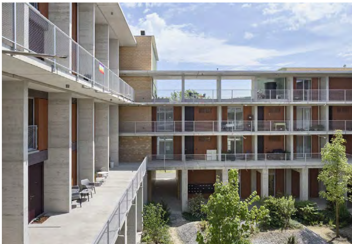
2 | Stanovanjska stavba Haus A
