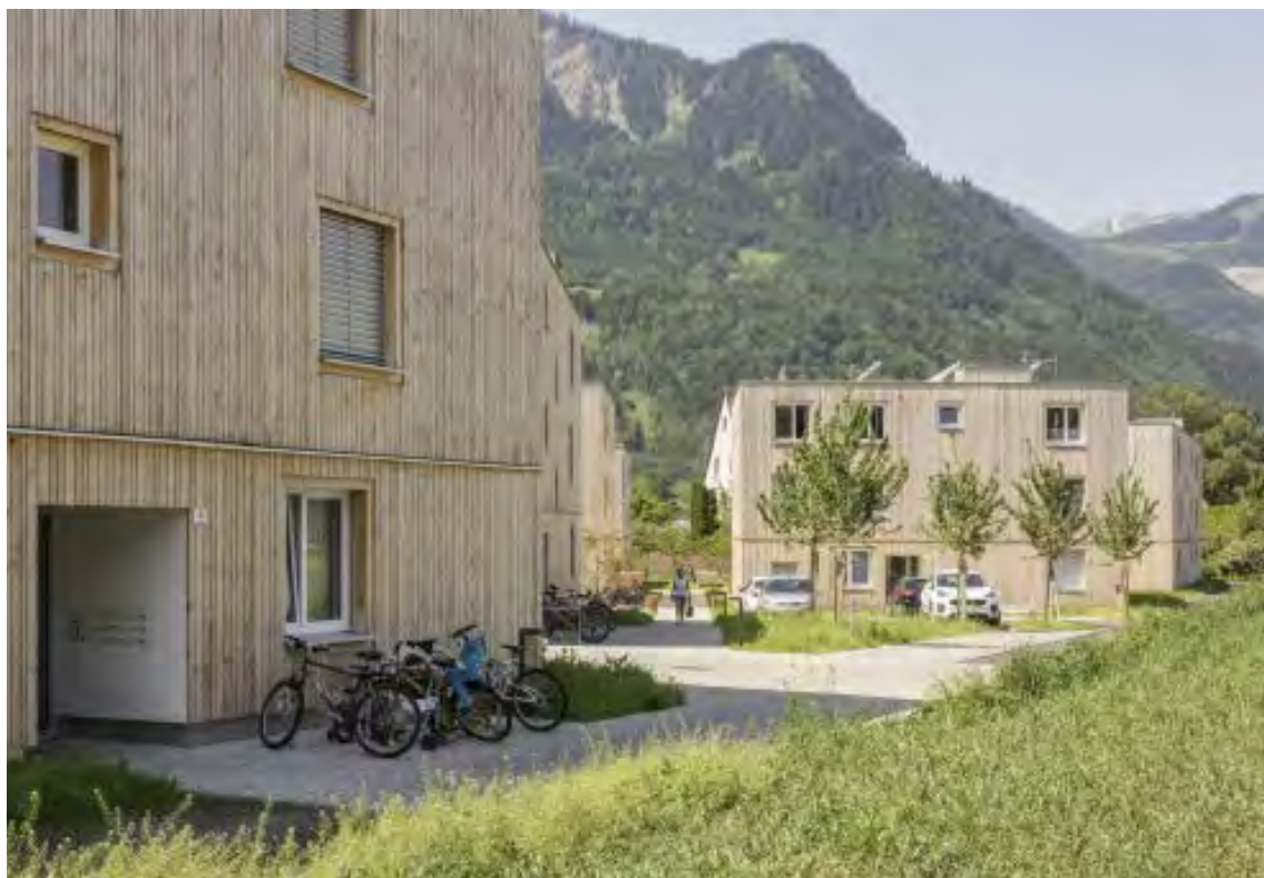
20 | Pogled na vhod stanovanjske stavbe
