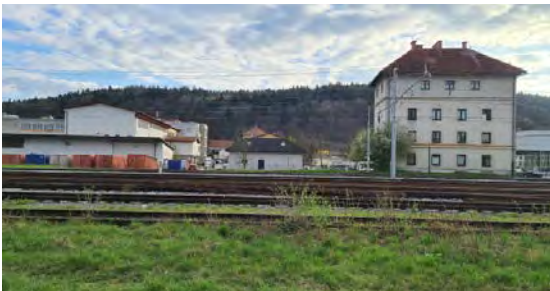
Slika 9: Pogled iz območja za stanovanjsko zidavo na predvideno lokacijo železniške postaje
