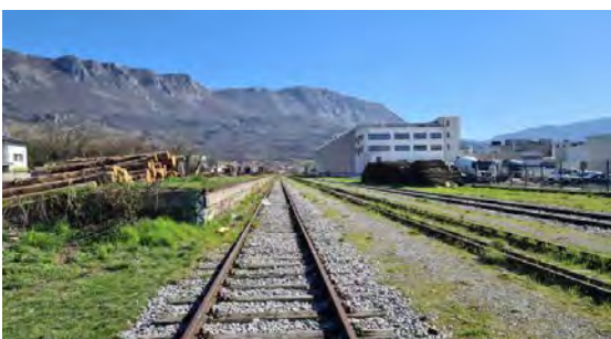
Slika 52: Obstoječi železniški tiri
